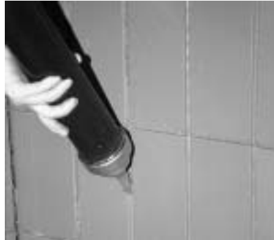
Ausspritzen der Fugen.
