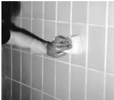
Schlämme aufnehmen mit Viskoseschwamm.
