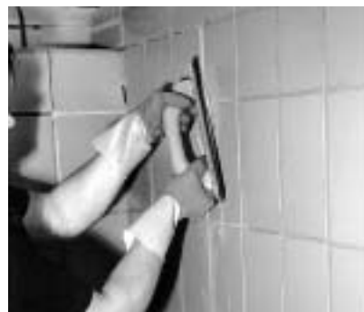
Einbringen mit Schlämmkelle.
